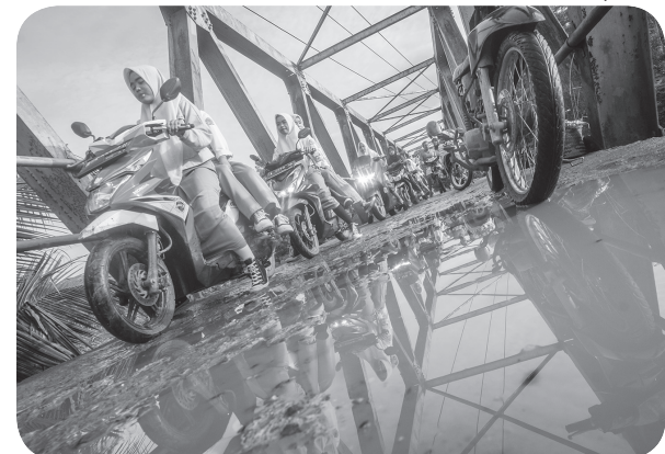
JEMBATAN RUSAK AKIBAT BANJIR BANDANG DI LEBAK
